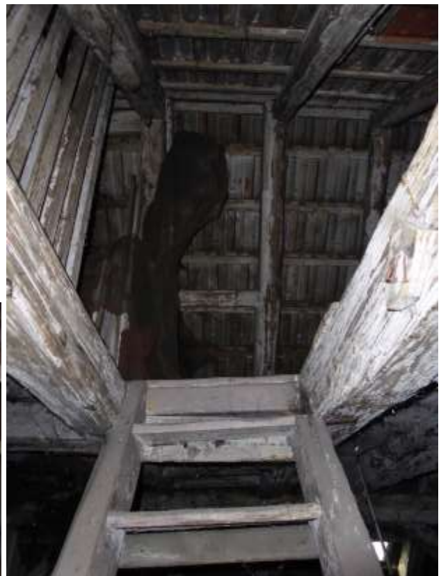
Blick von unten in den Dachboden.
