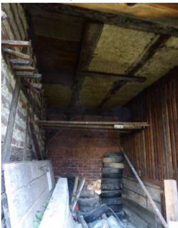
Nur durch Latten abgetrennter Raum.
