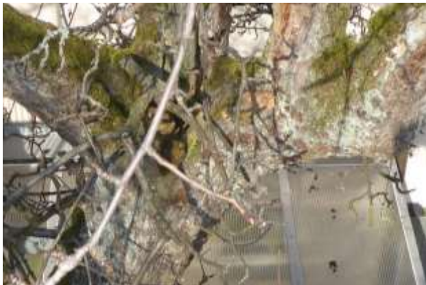
Weitere kritische, offene, marode Stelle in der Krone. Rechts unten Überdach des Nachbarhaus-Hintereingangs.
