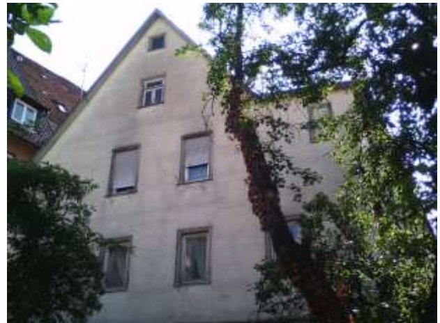
Haus Adlerstraße 2 vom Innenhof aus, Ansicht von Westen.
