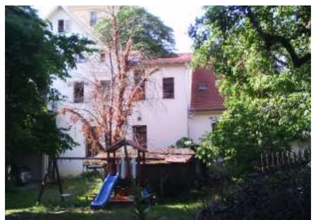
Blick vom nördlichen Innenhof nach Süden.
