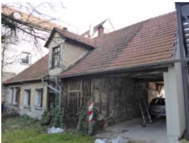
Rückansicht des Gebäudes Adlerstr. 2/1. Man beachte die offene Latten-Verkleidung links neben der Durchfahrt.
