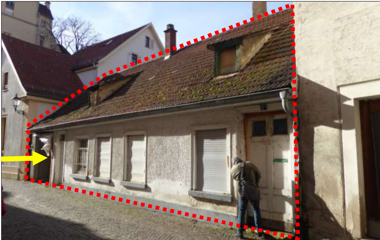
Abb. 2: Gebäude Adlerstraße 2/1, links Durchfahrt in den dahinter liegenden Garten (Pfeil).
