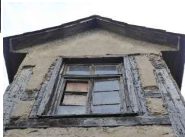
Um die Fensterrahmen der Gauben haben sich Lücken und Spalten gebildet, die für Fledermäuse gute Hangplätze sein können.
